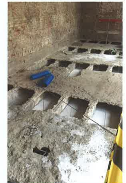
Fig. 8 Piscine de Saint-Josse-ten-Noode : renforcement par le dessus des dalles nervurées (2018 © AAC architecture).
