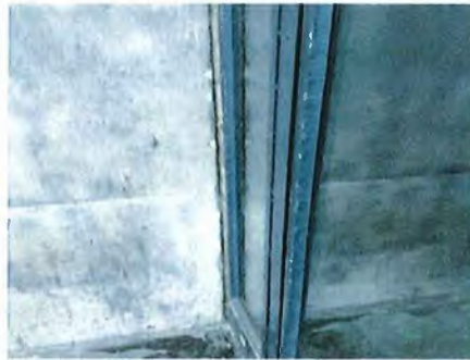
171 JOINT (À FAIRE PLUS RÉGULIER) 5/02/16 15:10 - Administrateur Chassis Chassis
